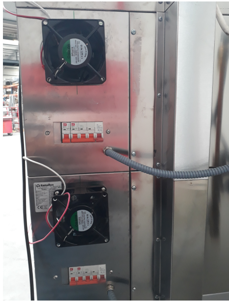
Figura 9.9: Ventiladores aplicados na traseira do forno, um por câmara.
