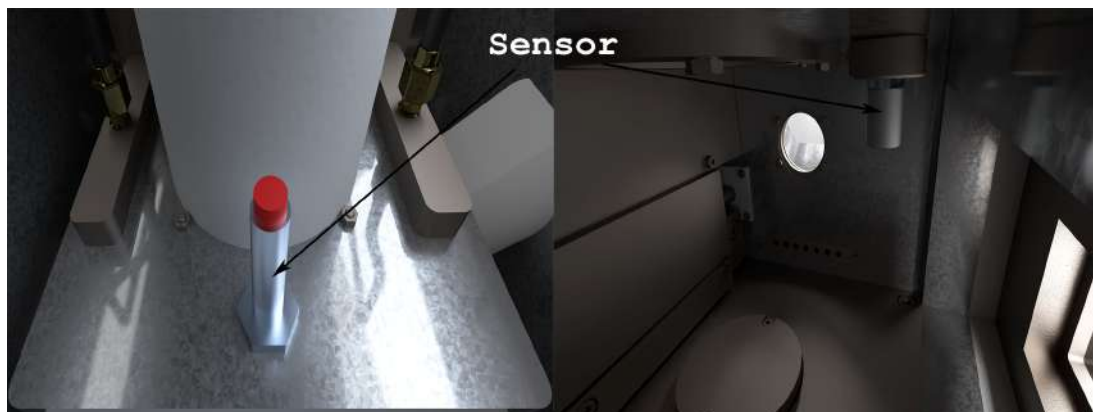
Figura 3.27: Instalação do sensor de oxigénio.
