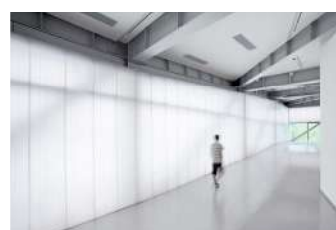
Figura 164 – Efeito da luz difusa pela aplicação de policarbonato na fachada, no interior do Sifang Art Museum, na China.
