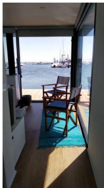
Figura 107 – Interior da Waterlily, onde é possível observar o pavimento flutuante vinílico.
