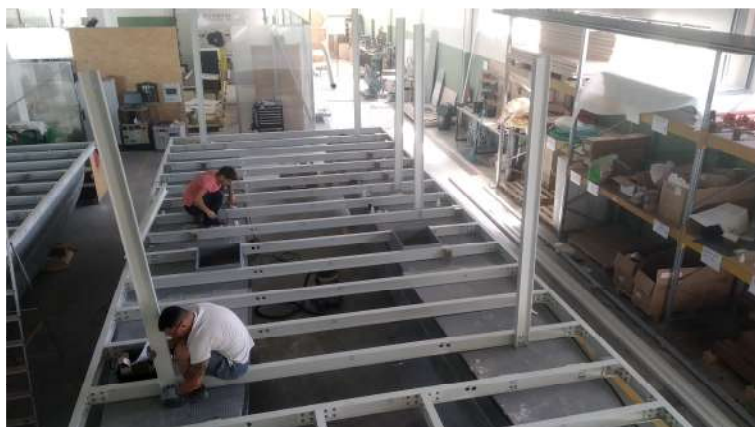
Figura 98 – Colocação dos pilares.
