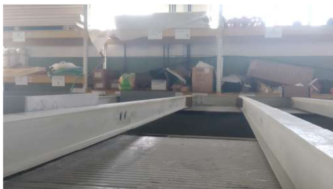
Figura 94 – Detalhe da aplicação das vigas da estrutura base.
