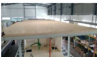
Figura 103 – Aplicação dos painéis sandwich que correspondem à cobertura.
