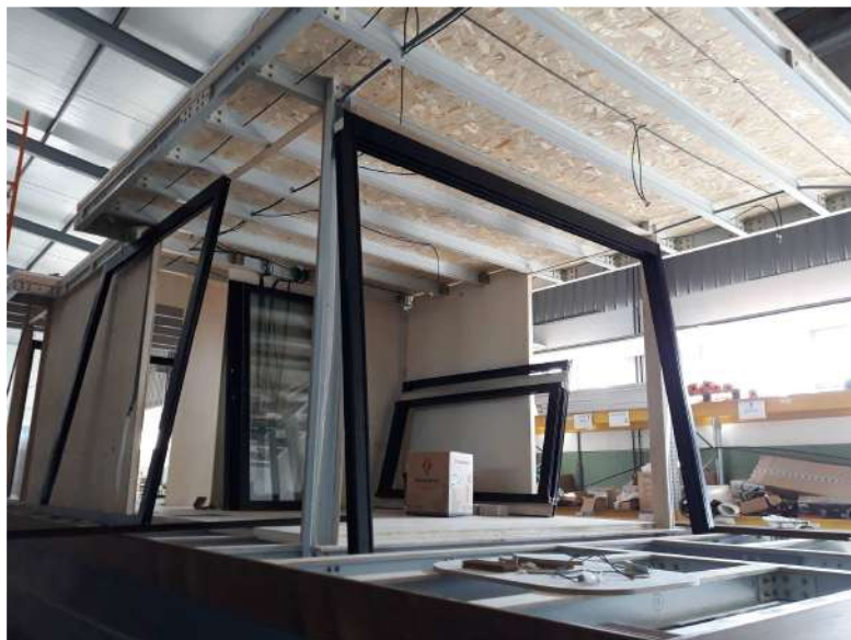
Figura 104 – Processo de aplicação da caixilharia na Waterlily.
