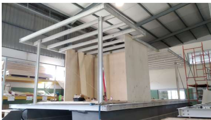
Figura 101 – Processo de colocação das paredes na Waterlily.
