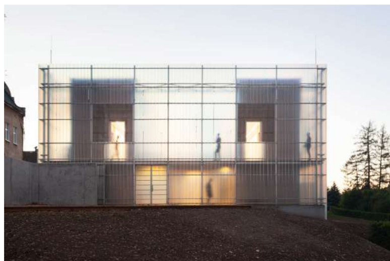
Figura 165 – Exemplo de uma fachada com painéis de fibra de vidro translúcida, no jardim de infância Nová Ruda, na República Checa.
