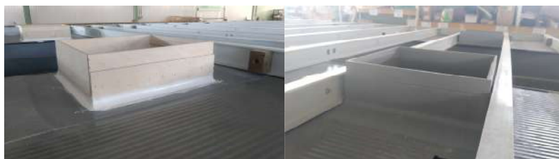
Figura 95 – Caixa porta-homens, antes e depois de ser fibrada, respetivamente.
