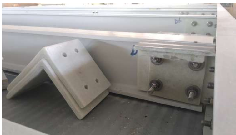
Figura 96 – Ligação entre vigas, utilizando cantoneiras e parafusos.
