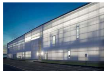
Figura 163 – Exemplo de uma fachada em painéis de policarbonato translúcido.
