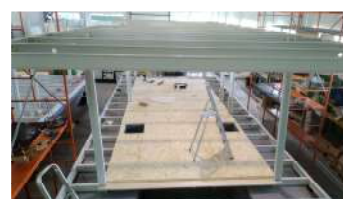
Figura 100 – Pavimento aplicado na estrutura da Waterlily.
