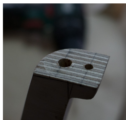
figura 115. Furação predefinida destinada a cavilha e parafuso de aperto.
