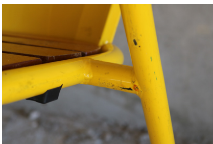
figura 50. Ligações entre componentes.
