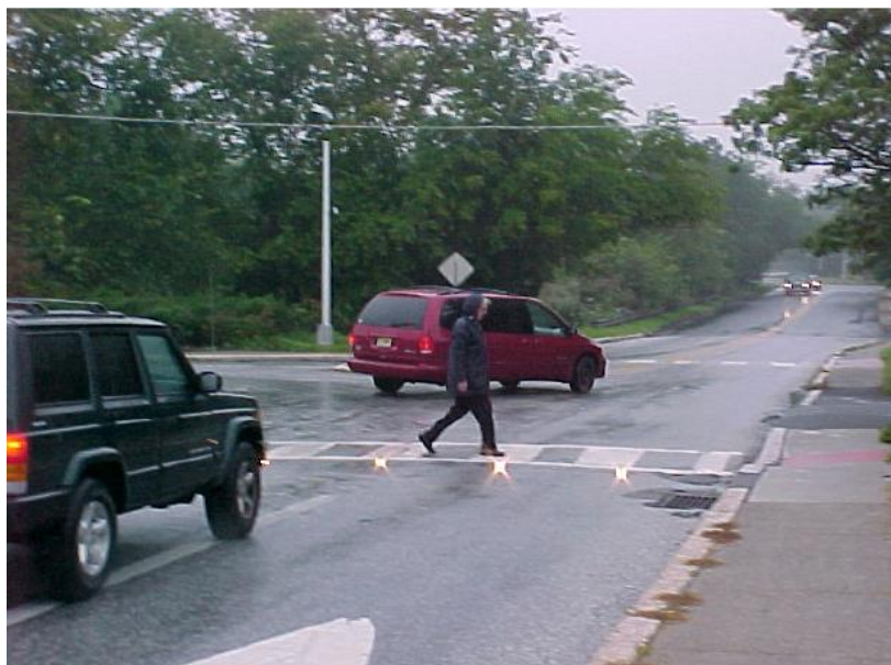
Figura 5. Aplicação de um sistema de sinais luminosos no pavimento (Derlofske et al., 2003).
