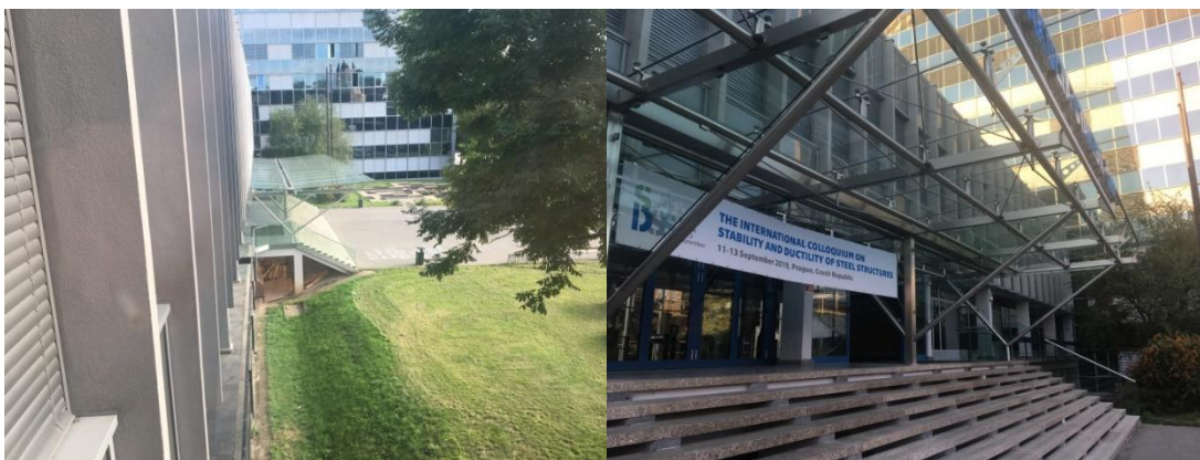
Figura 4. Cobertura, Universidade Técnica Checa (CTU), Praga, 2019
