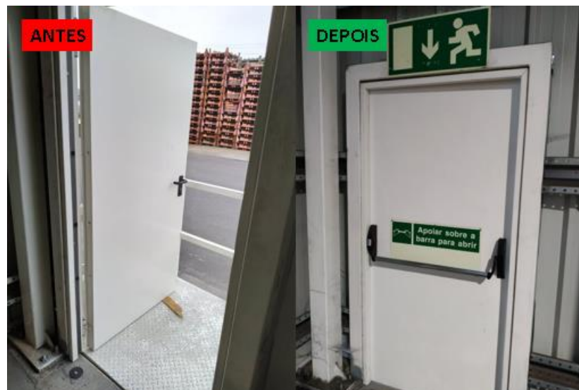
Figura 26 - Aplicação do manípulo da porta de emergência
