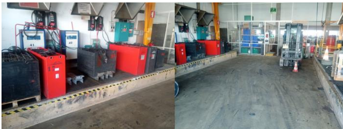
Figura 21 - Condições físicas da Garagem de Manutenção
