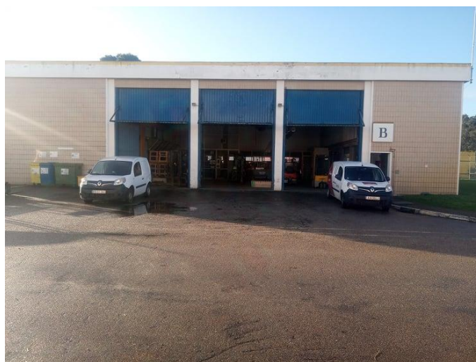
Figura 20 - Garagem de Manutenção
