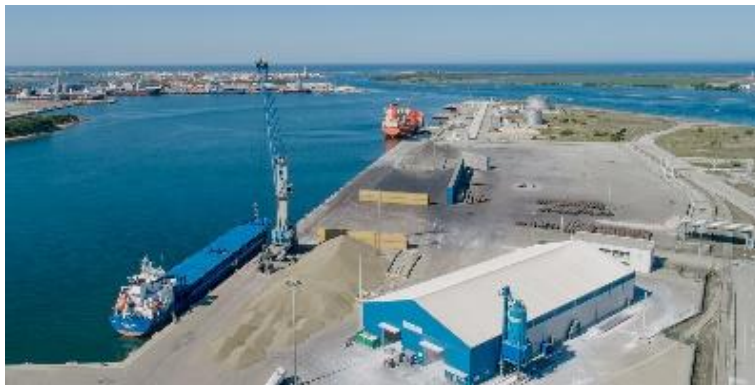
Figura 24- Terminal de Granéis Sólidos - (APA, S.A., 2020)
