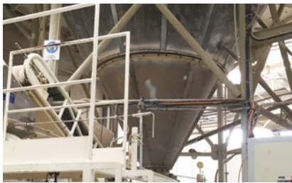
Figura 10 - Atomizador.
