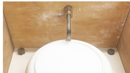
Figura 16 - Colocação do jito de enchimento.
