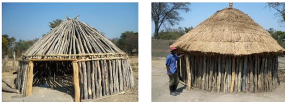
Figura 3 - Fases da construção de uma casa de pau-a-pique (retiradas de Dias, 2016, p. 142 e 143)
