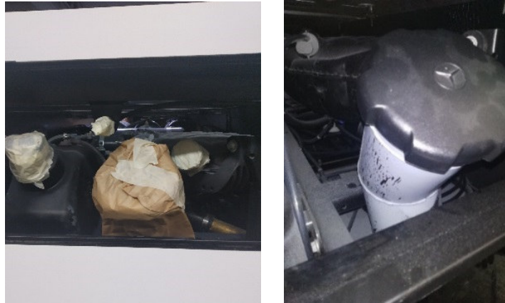
Figura 62 - Isolamento do Depósito do Gasóleo com Fita.
