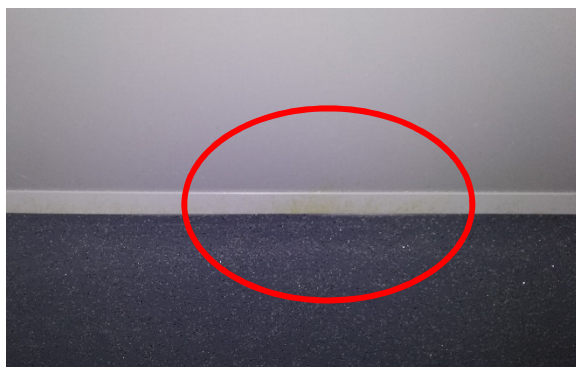
Figura 80 - Cola nos Painéis.
