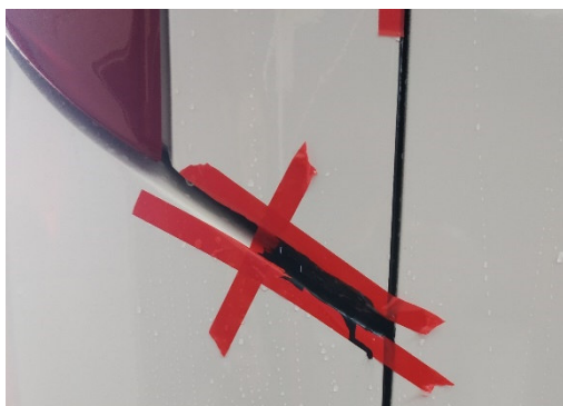
Figura 79 - Falha na Estrutura Retificada.
