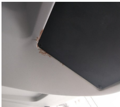
Figura 13 - Pintura Danificada.
