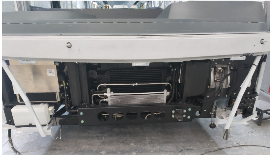
Figura 30 - Falta de Tinta na Estrutura da Frente.
