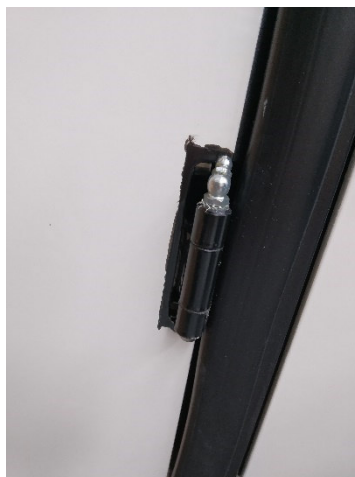
Figura 75 - Parafuso e Berma Após Pintura.
