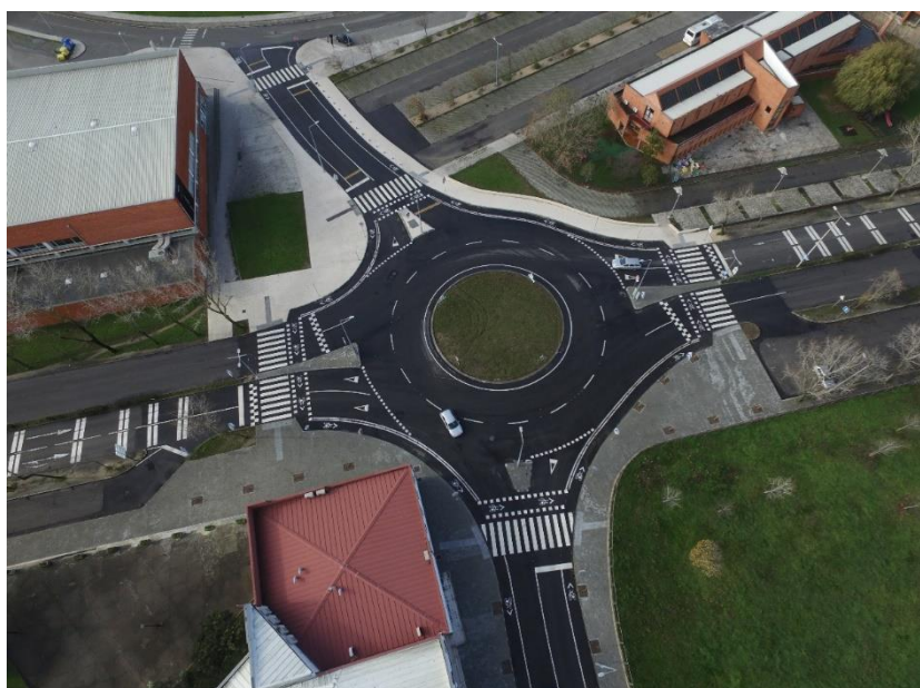
Figura 9 - Vista aérea do resultado da reformulação do nó da Avenida da Universidade
