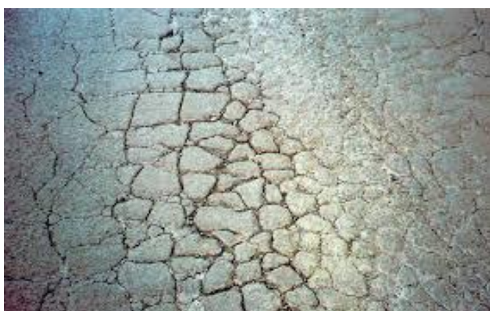
Figura 12 – Fendilhação “pele de crocodilo” (Neves, 2017)
