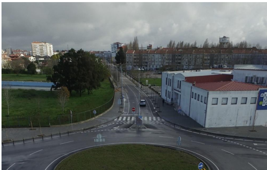
Figura 8 - Rua Associação Humanitária dos Bombeiros Voluntários após trabalhos de reabilitação (Pata, 2019)
