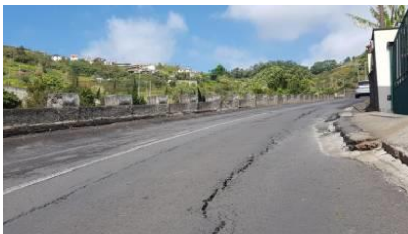
Figura 11 - Exemplo de abatimento num pavimento (Madeira, 2018)
