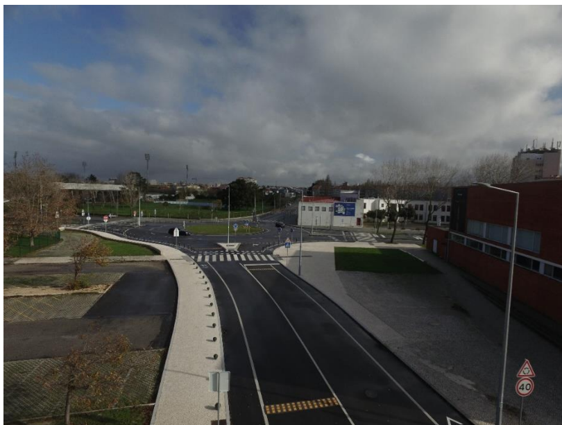
Figura 7 - Novo acesso ao Campus da UA depois da intervenção (Pata, 2019)
