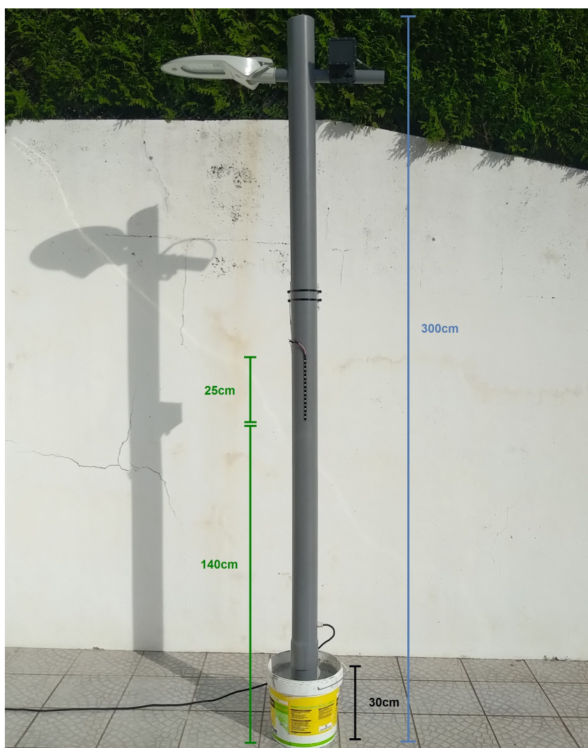
Figura 4.26: Visão lateral do poste, voltado para a via (detecção de velocidade)
