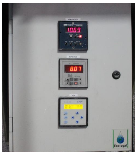
Figura 4.12: Controlador dos valores de pH medidos por elétrodos dispostos à entrada e saída do primeiro reator.
