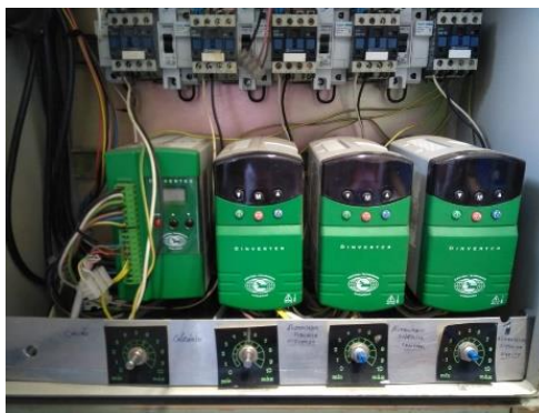
Figura 4.5- Controlador digital do moto-reductor.
