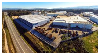
Figura 1.1 – Pecol – Sistemas de fixação, em Águeda. [1]
