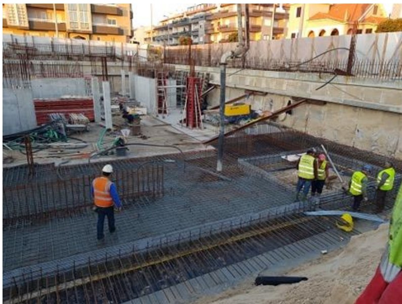
Figura 16 - Aplicação de Sika Water Bar nas juntas de ensoleiramento
