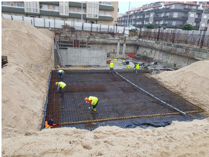
Figura 4 - Evolução dos trabalhos no ensoleiramento geral da obra "Lux"
