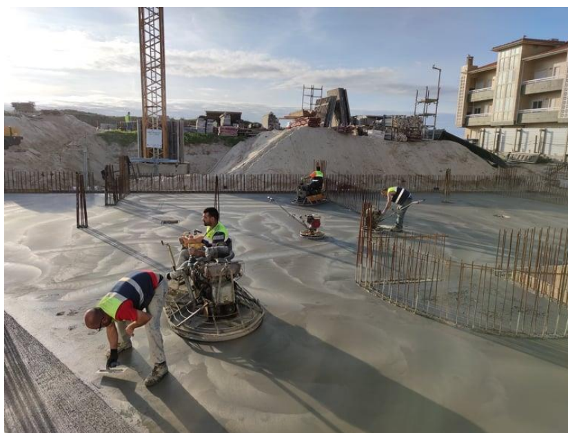
Figura 22 - Acabamento dado na laje do piso -1
