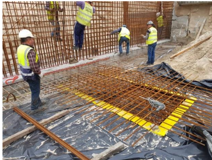
Figura 15 - Elementos do ensoleiramento geral
