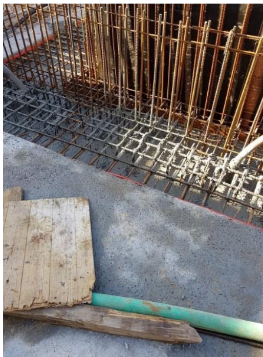
Figura 13 - Betonagem da caixa de elevador
