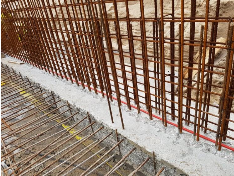
Figura 18 - Armadura dos muros perimetrais
