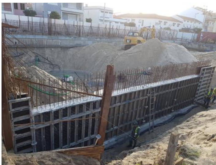
Figura 19 - Betonagem feita num dos muros perimetrais do edifício em estudo
