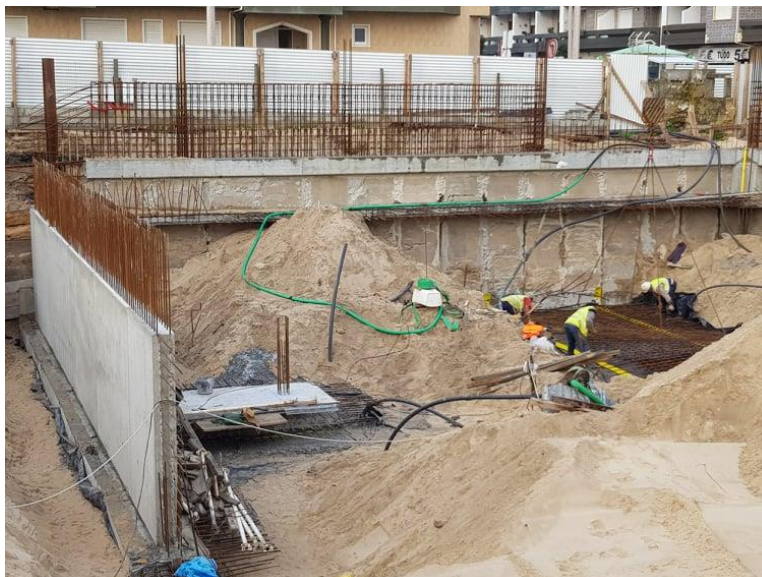
Figura 8 - Muro perimetral de suporte em consola
