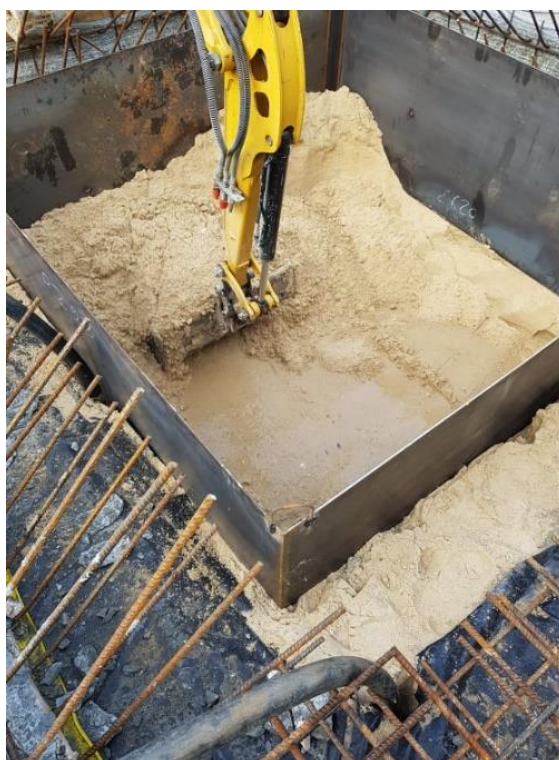
Figura 11 - Abertura da caixa de elevador
