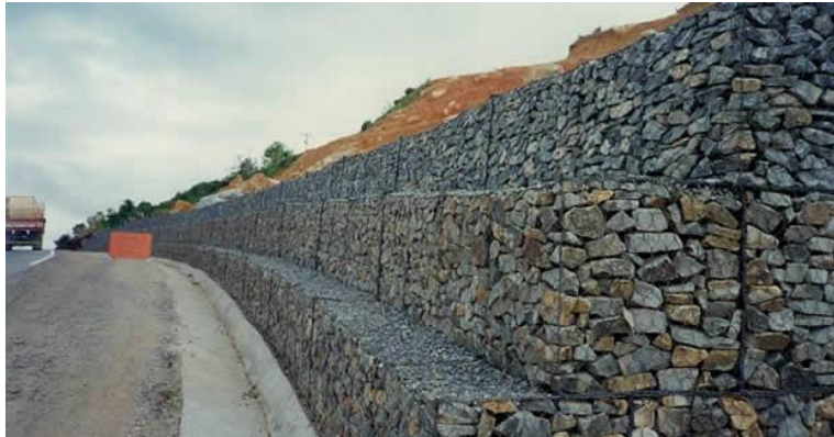
Figura 25 - Muro de Gabiões
