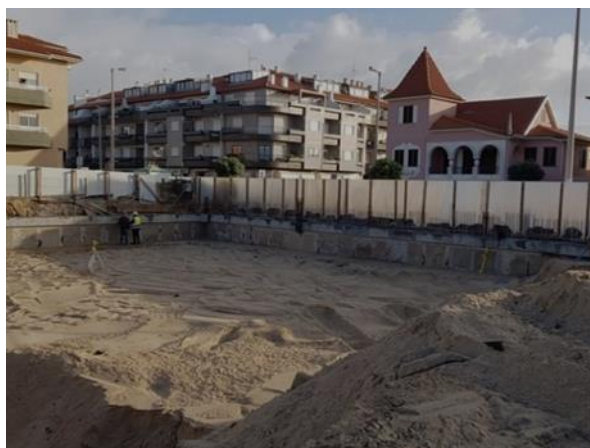
Figura 1 - Muro de contenção com paredes moldadas
