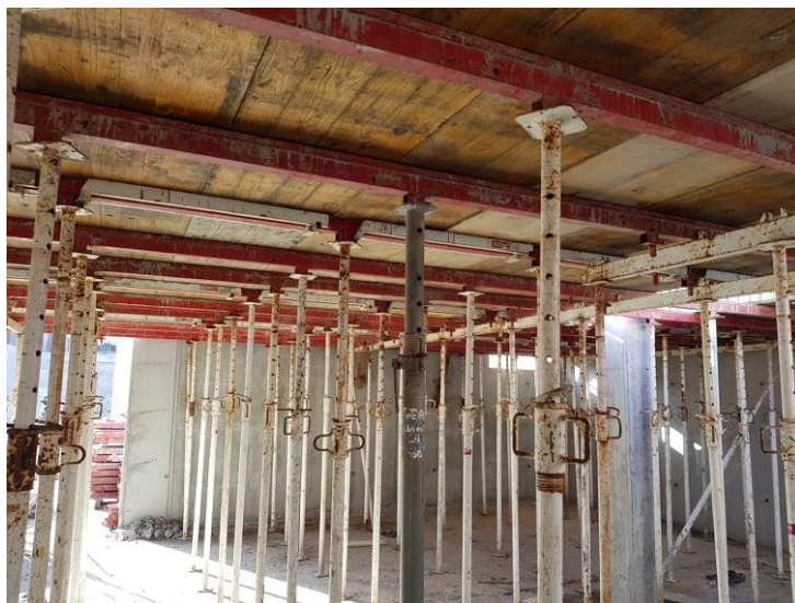
Figura 20 - Colocação de escoras de suporte para a laje do piso -1
