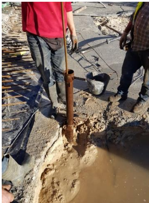
Figura 10 - Colocação das agulhas de drenagem
