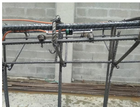
Figura 20 – Colocação sensores internos
