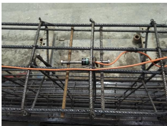
Figura 20 – Colocação sensores internos
