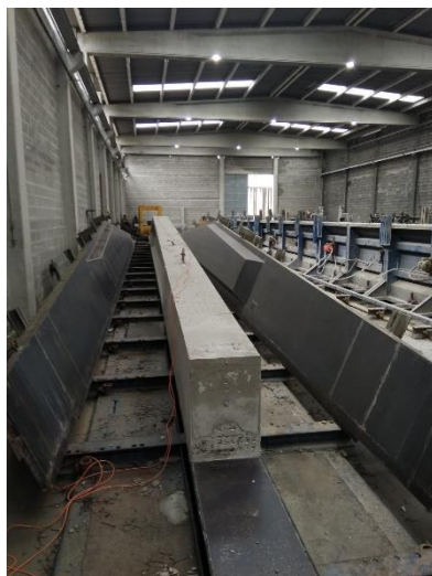
Figura 23 – Descofragem da viga
