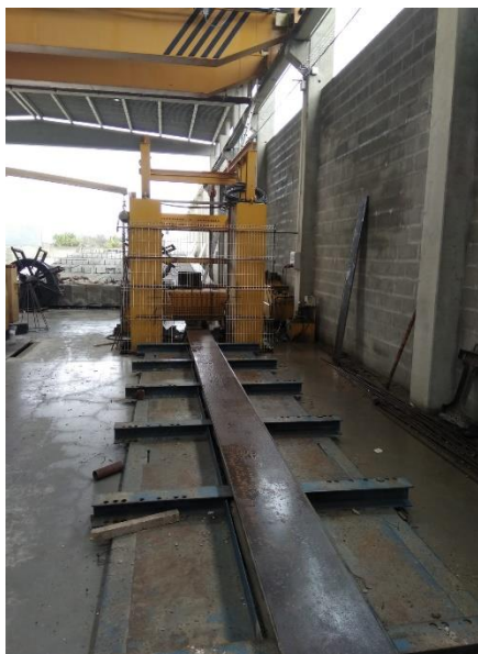
Figura 18 – Ancoragem de pré-esforço
