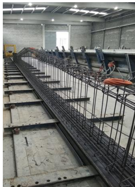
Figura 19 – Armadura das vigas
