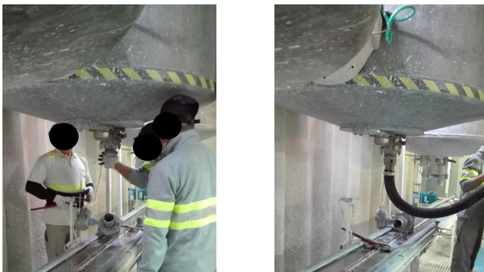
Figura 48 – Etapa de montagem da mangueira no misturador que vai alimentar a panela.
