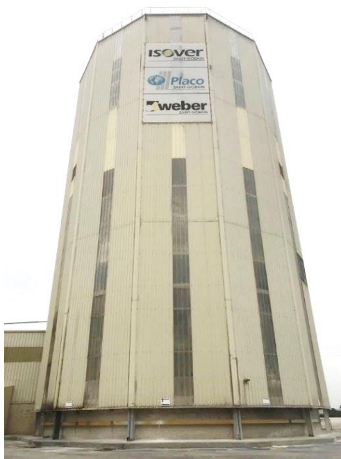
Figura 10 - Torre da linha CA 25-30.
