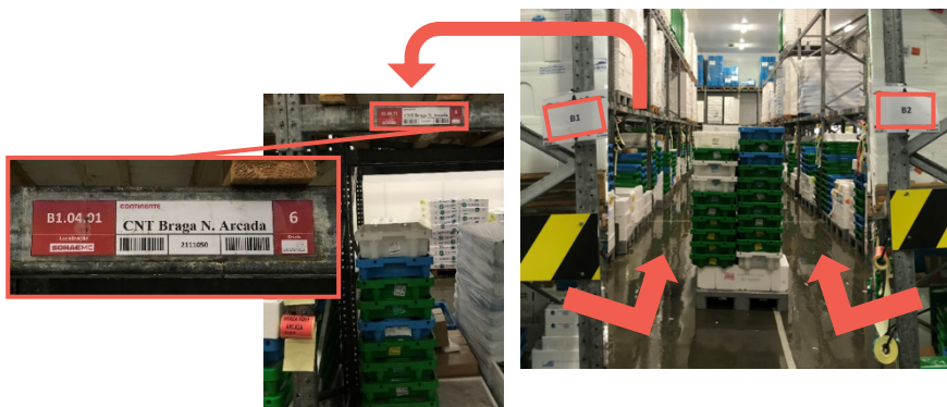
Figura 34. Câmara de Preparação. Esta câmara é constituída por estruturas de suporte e no nível mais inferior das estruturas encontram-se as localizações (lojas) identificadas por um código. Estas localizações encontram-se distribuídas pelos dois lados do corredor (por exemplo B1 e B2). Os níveis superiores das estruturas são utilizados para stock.
