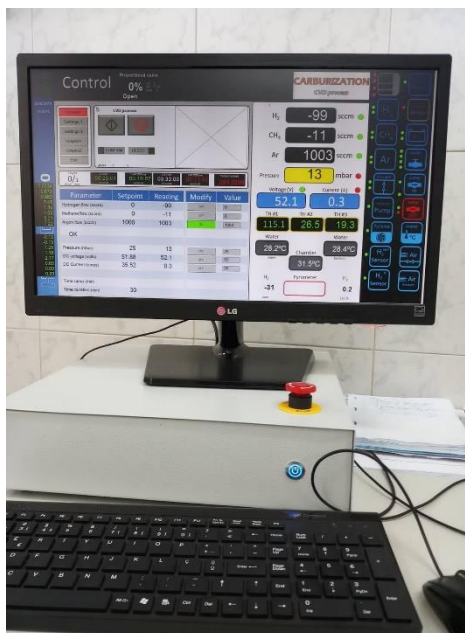
Figura 3: Sistema de controlo/aquisição de dados.
