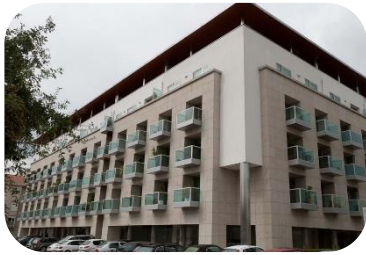
Residências do Paço Braga
