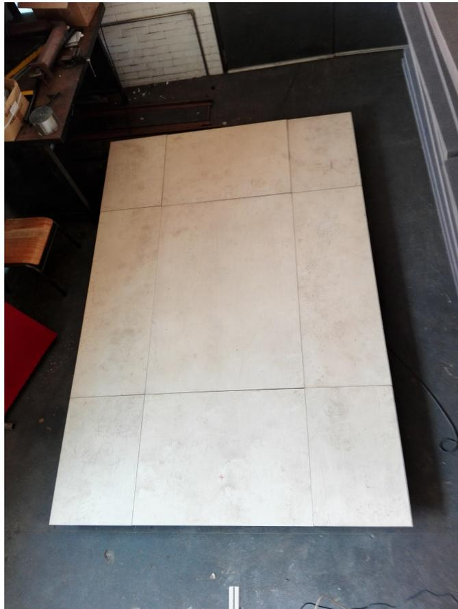
Figura 2.8: Montagem das placas superiores
