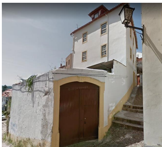
Figura 2.2 – Edifício explorado para a gestão de AL
