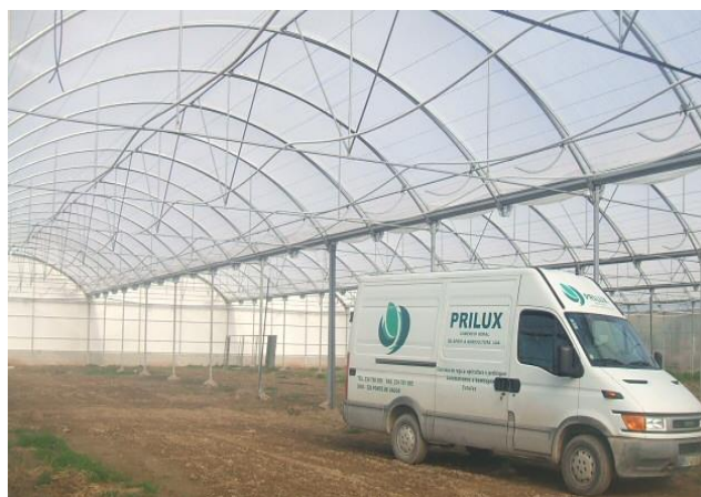
Figura 18 - Obra - Construção de uma estufa
