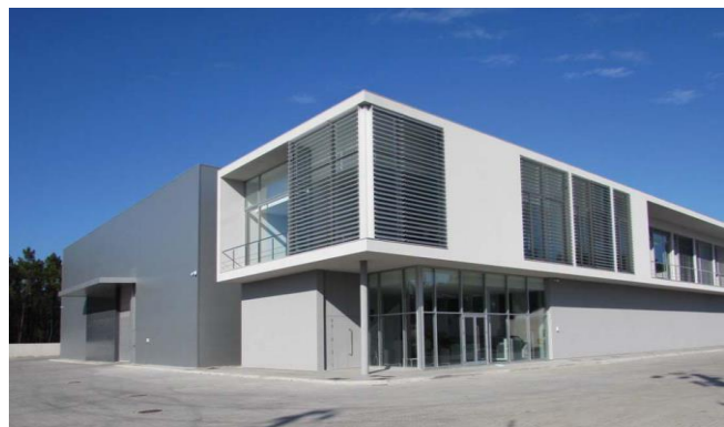
Figura 20 - Instalações da Prilux
