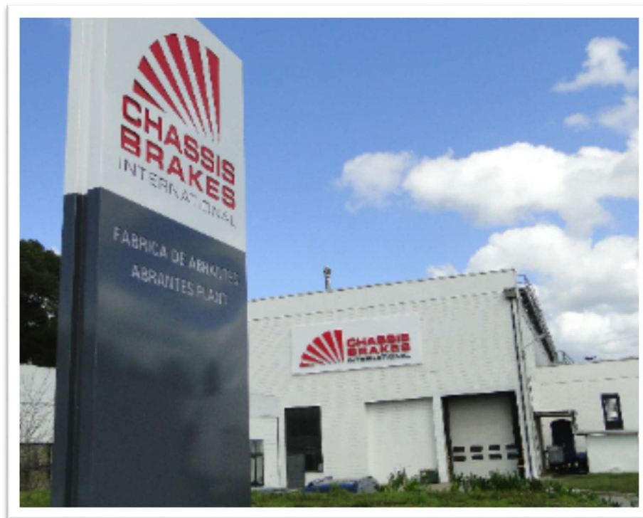
Figura 1. Fotografias edifício da CBI Abrantes
