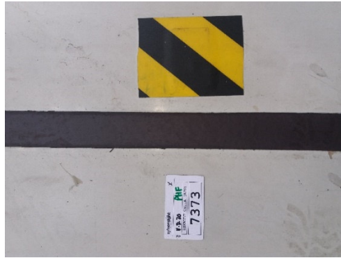
Figura 30: Exemplo de um troço de circuito representado pela fita magnética e pelas tags que são lidas em ambos os sentidos de transição.
