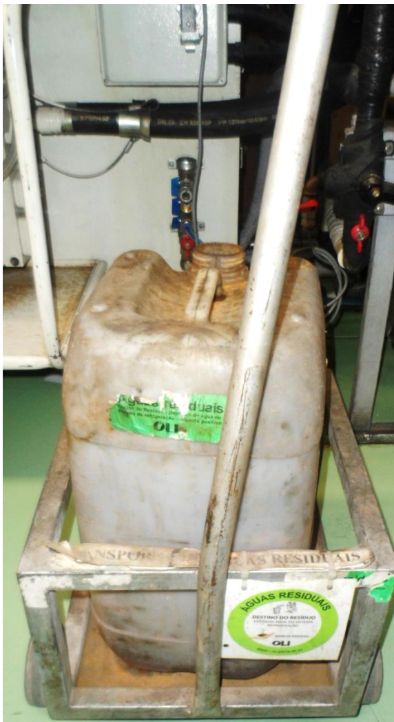
Figura 38: Pote de Sopro de Água (Antes)
