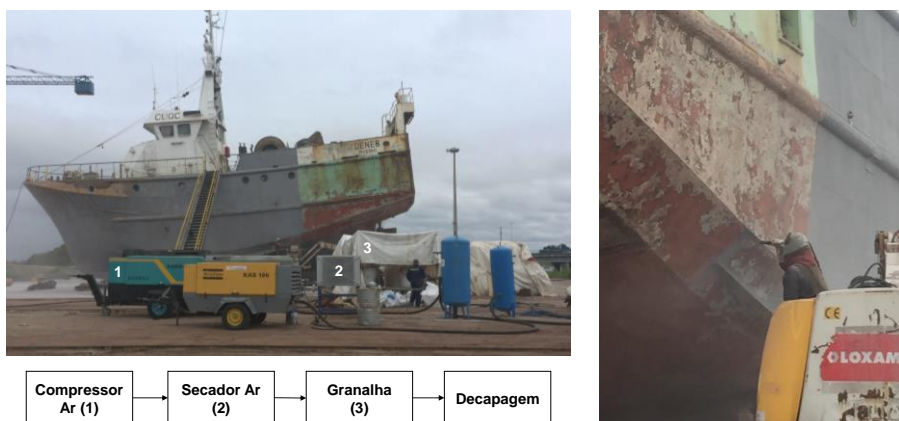
Figura 4 – Material necessário para realizar a decapagem e esquema de sequência do processo e o equipamento dos trabalhadores.
