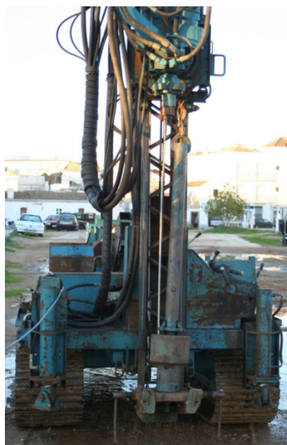
Figura 10 - Equipamento de cravação
