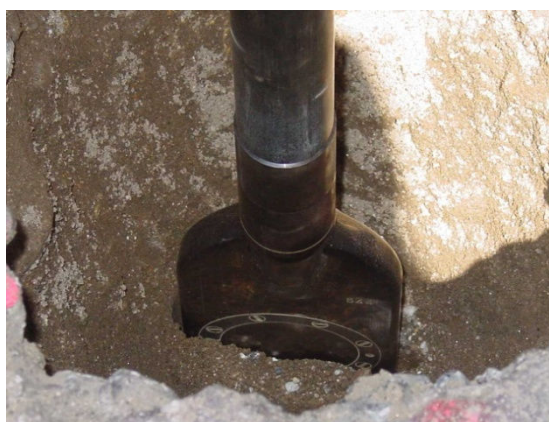
Figura 16 - Cravação da lâmina
