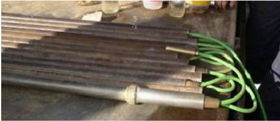
Figura 51 - Cabo de ligação a passar pelo interior dos tubos
