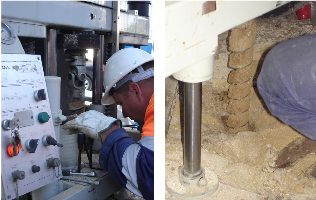
Figura 133 - Realização do furo
