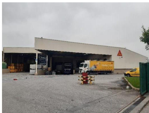
Figura 2.1: Instalações da Sika Portugal em Ovar.
