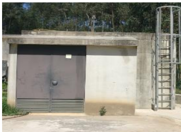
Figura 18. Estação elevatória da ETAL da Recivalongo.
