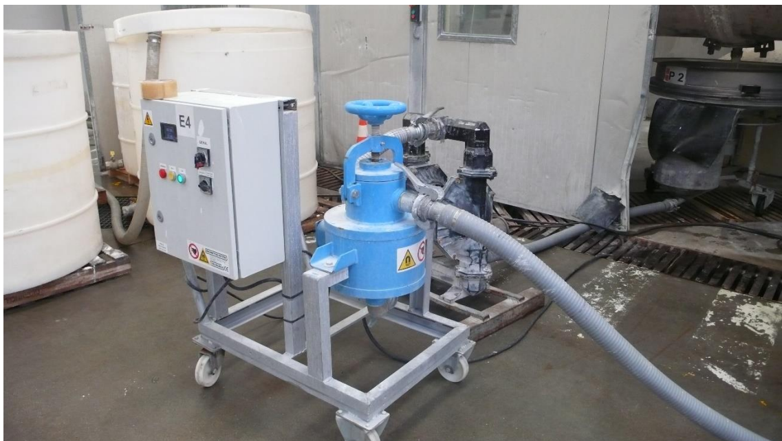
Figura 4 – Descarga de um moinho, passagem pelo peneiro de descarga (P2) e pelo eletroímã (E4).
