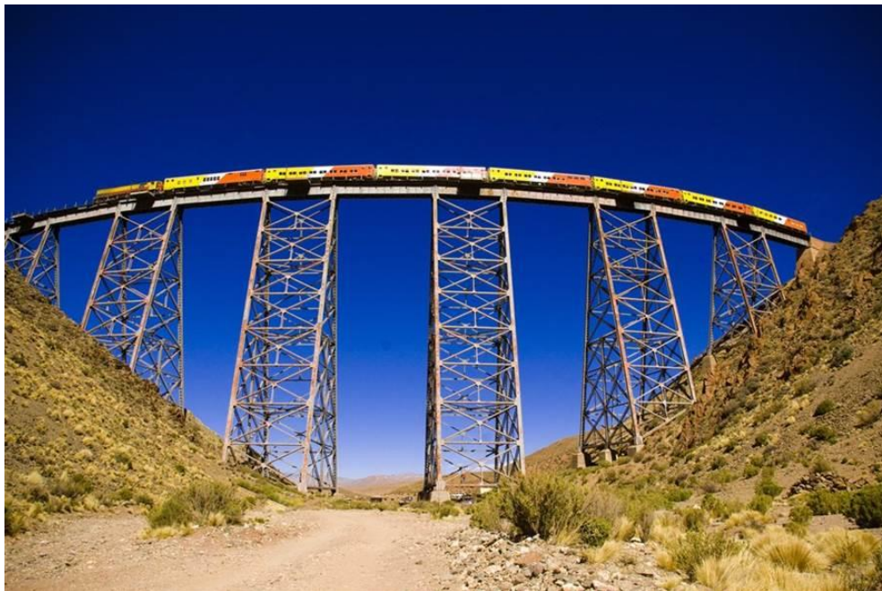
Figura 28 | Vista do Viaduto de La polvorilla quando passa o comboio
