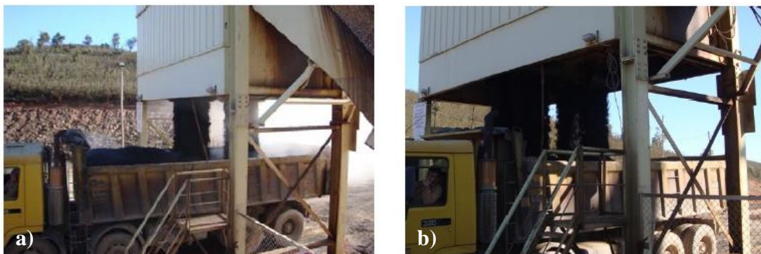
Figura 5 - Emissões de gases e fumos no momento da descarga de misturas betuminosas: a) MBQ; b) MBT ( Ferreira, 2009 )
