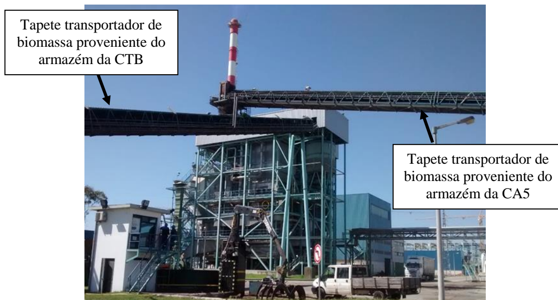
Figura 4.14. Vista traseira da CTB.
