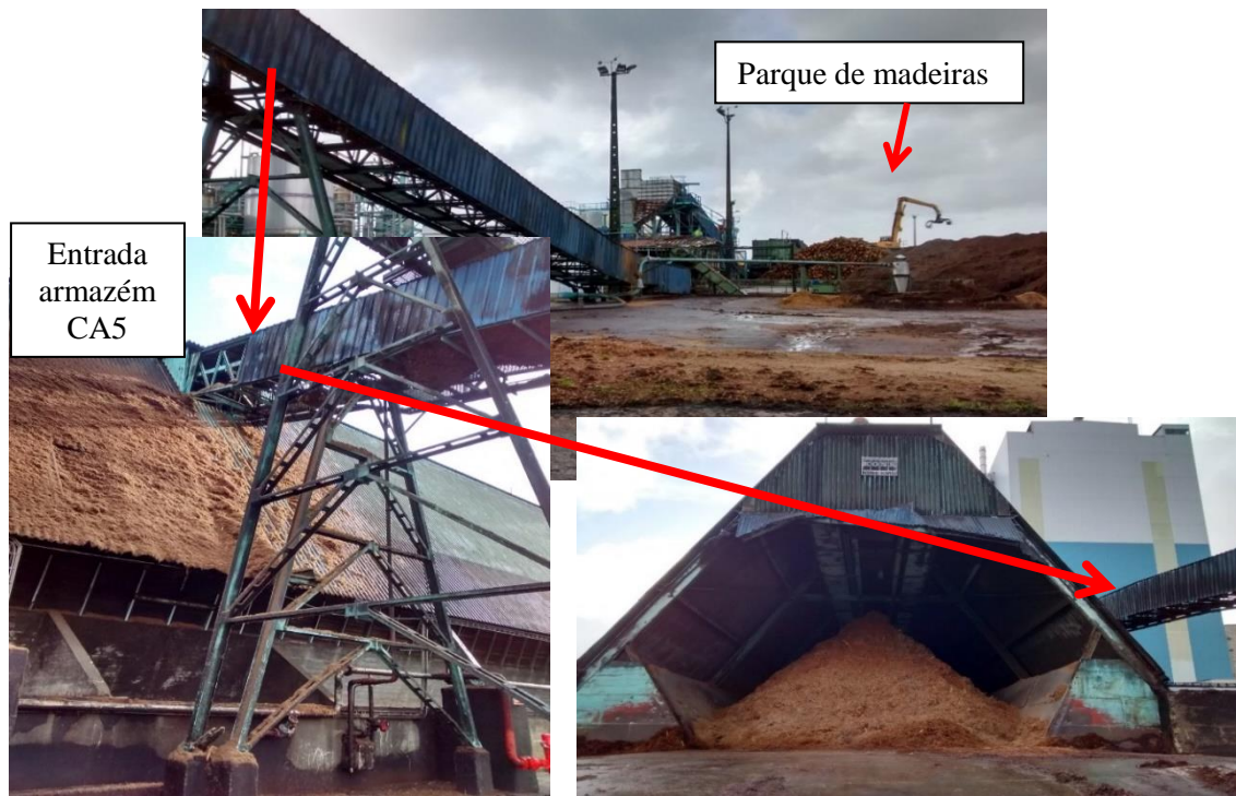
Figura 4.2. Encaminhamento da biomassa desde o parque de madeiras até ao topo do armazém de biomassa da CA5, através do tapete transportador.
