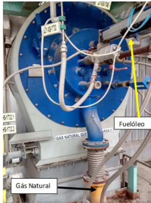
Figura 4.9. Queimador de carga.
