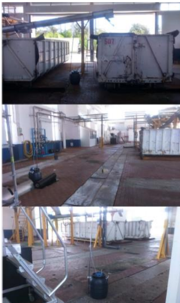
Figura 19: ETAR de Ribeira de Moinhos - Edifício de secagem de lamas. Fonte: IDAD (2017b)
