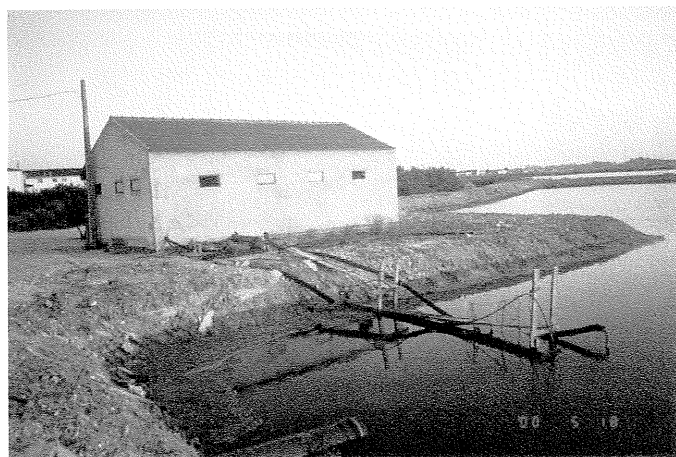
Anexo III: Fotografia do exterior da estação experimental: (a) reservatório principal; (b) captação de água no reservatório de saída da piscicultura.
