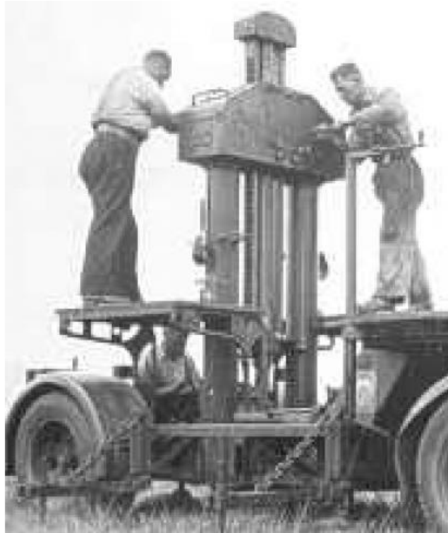
Figura 5.2 - Ensaio CPT operado manualmente.
