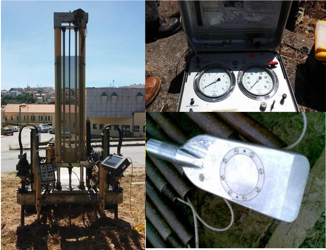
Figura 4.5 - Execução no campo do ensaio DMT.
