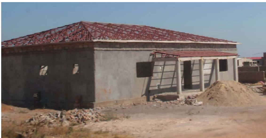
Figura 72 – Habitação para classe média alta em construção
