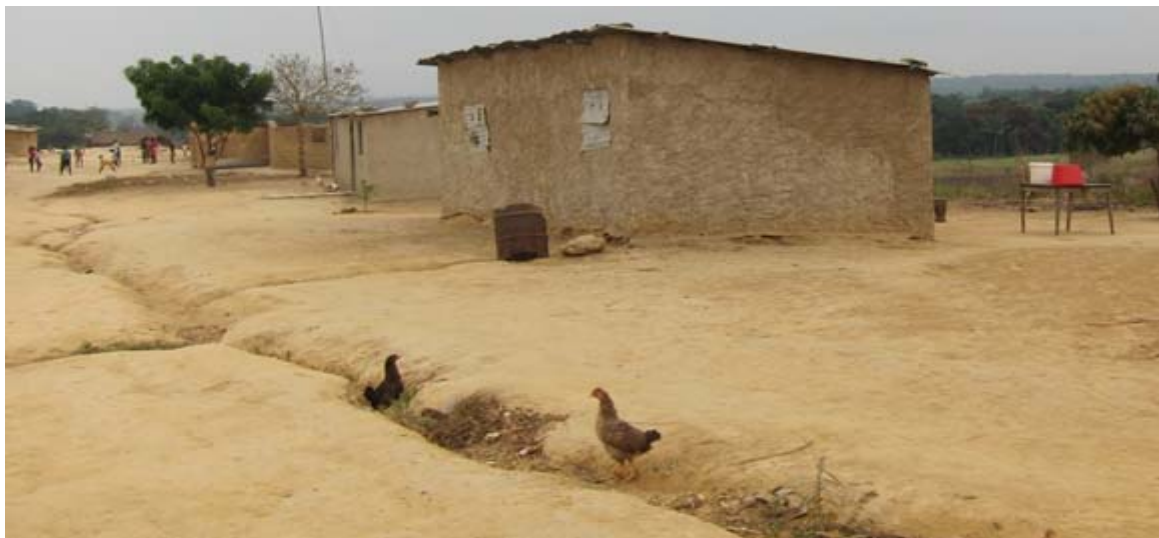
Figura 88 - Falta de drenagem de águas pluviais e resíduos no meio da rua
