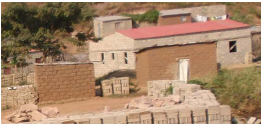
Figura 75 – Substituição das construções tradicionais por construções em alvenaria de blocos de argamassa de cimento.
