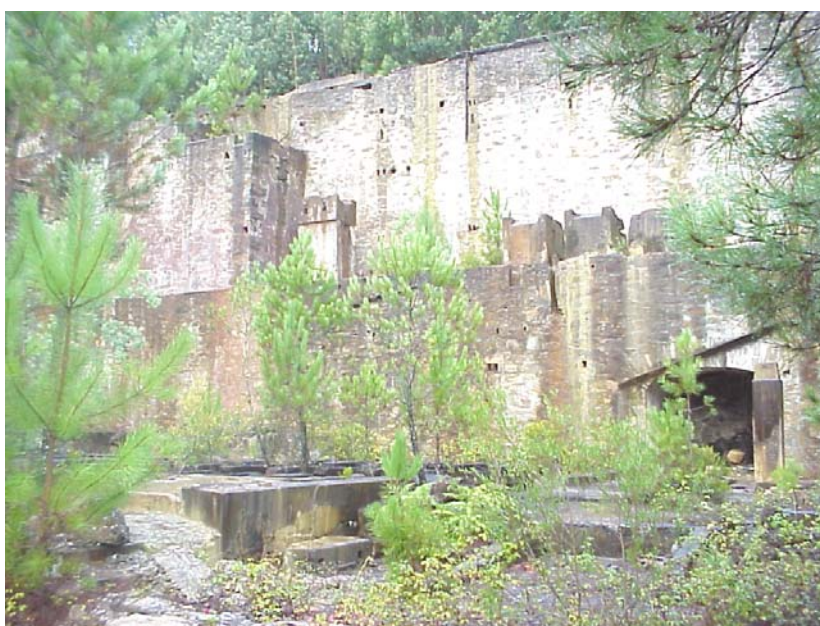
Figura 4.3 - Fotografia das antigas instalações da mina.
