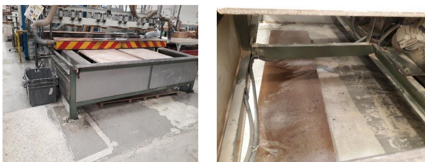
Figura 34 - Limpeza do espaço ao redor das máquinas e do seu interior
