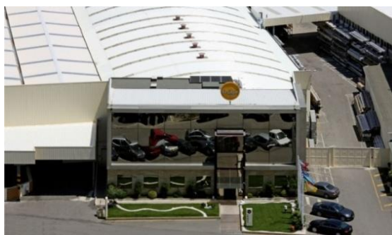
Figura 7 - Instalações da Bi-Silque
