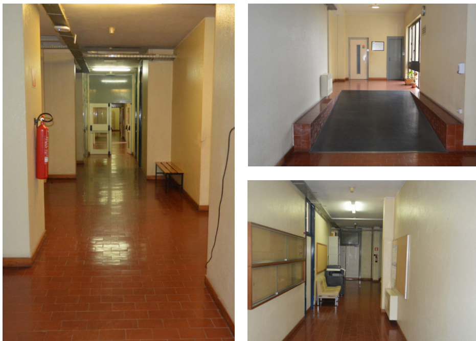
Figura 3. Corredores - primeiro e segundo andar do DETI
