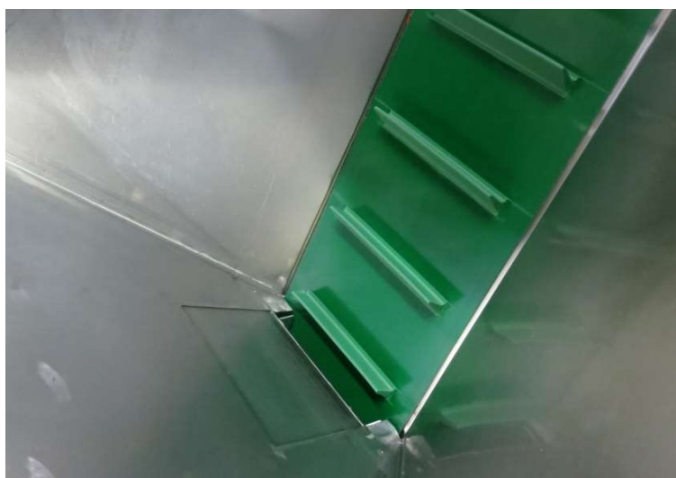
Figura 56: Intervenção nas válvulas
