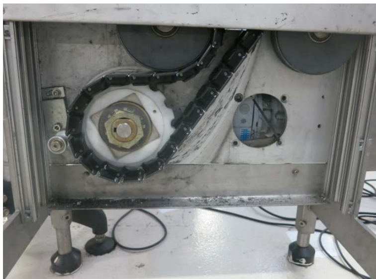
Figura 59: Intervenção nos transportadores
