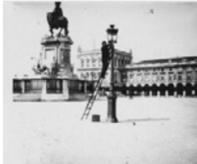
Fig. 5 Primeiro candeeiro elétrico em Lisboa, Portugal Fonte: http://revelarlx.cm-lisboa.pt/gca/?id=1246
