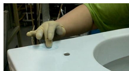
Figura 11 - Ilustração do modo de aplicação da cola.
