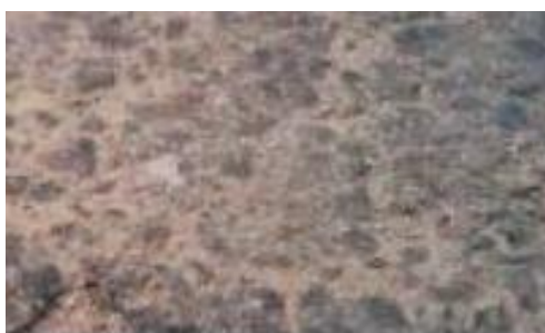
Figura 11 - Cabeça de gato, fonte: (slides da UC Conservação e Reabilitação de Pavimentos Rodoviários da Universidade de Aveiro).
