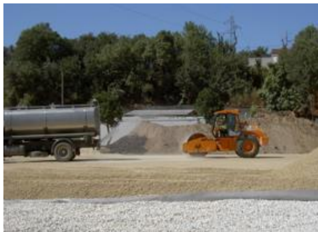
Figura 29 - Rega e compactação da camada de base.
