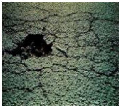
Figura 10 - Degradação Superficial, (Transportation, 2003).
