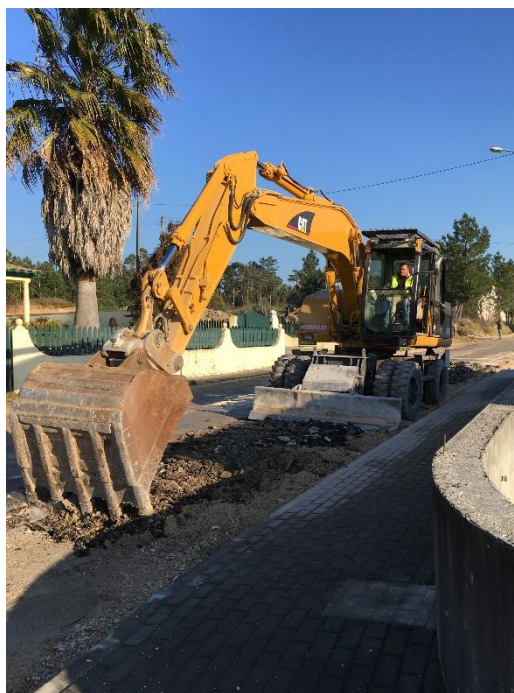
Figura 27 - Escarificação do pavimento existente.
