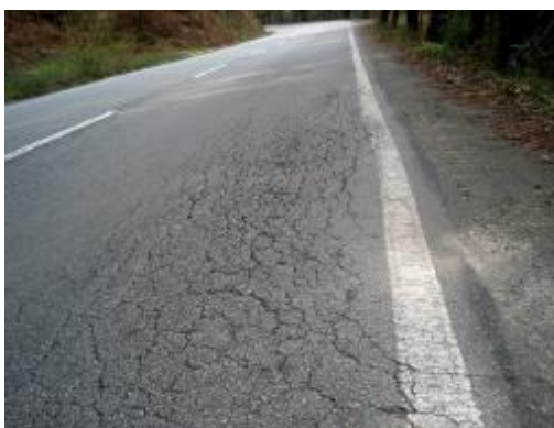
Figura 8 - Fendas por fadiga, fonte: (slides da UC Conservação e Reabilitação de Pavimentos Rodoviários da Universidade de Aveiro).
