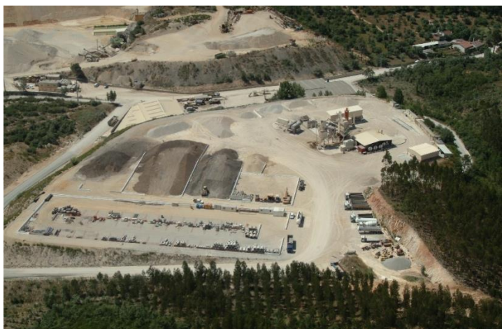
Figura 44 - Vista aérea da central de produção de misturas betuminosas, Redinha, Pombal.
