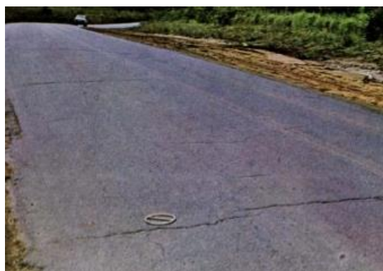
Figura 7 - Fendas transversais, (DNIT, 2003).
