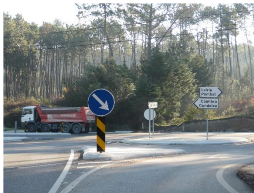
Figura 41 - Execução de sinalização vertical.
