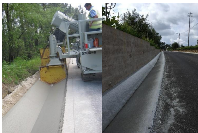
Figura 33 - Execução de valetas com recurso a máquina de moldagem in situ .
