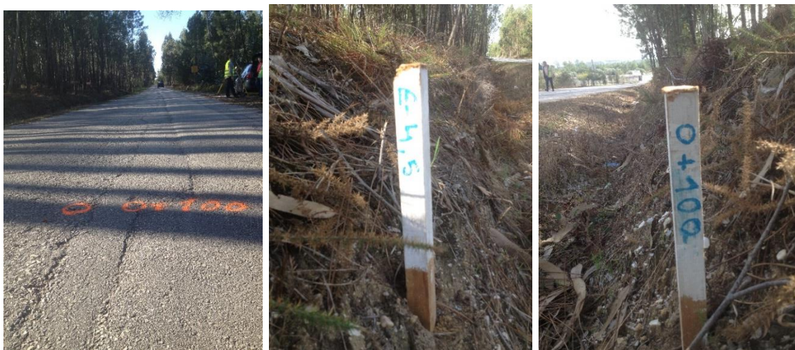
Figura 25 - Colocação de estacas e marcação do eixo.
