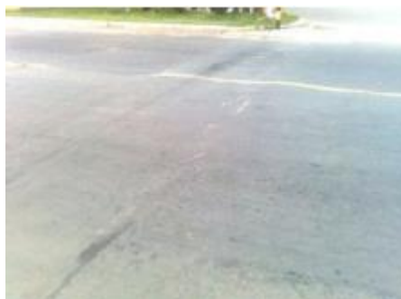
Figura 2 - Ondulações em frente a um posto de combustível, (da Rocha & Costa, 2009).
