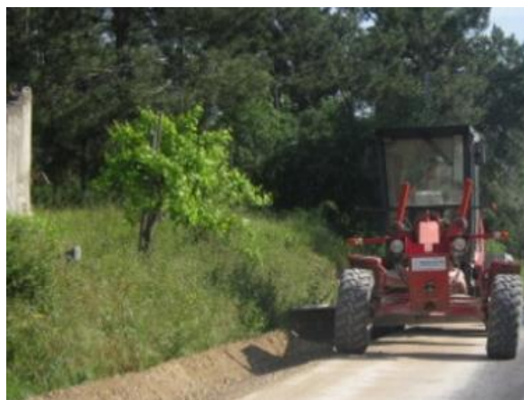
Figura 32 - Reperfilamento de valetas com recurso a motoniveladora.
