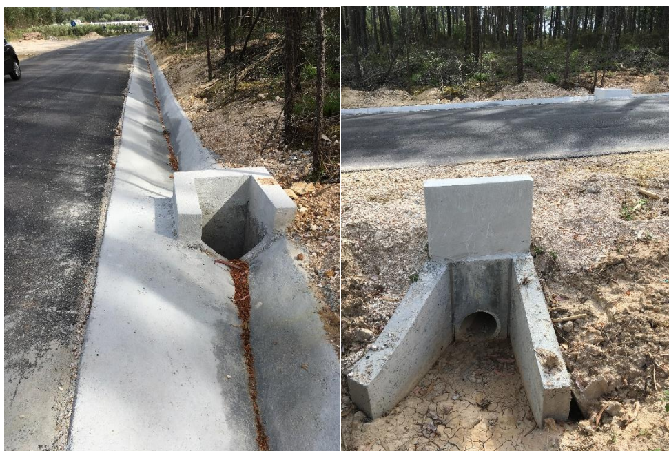
Figura 31 - Elementos de drenagem longitudinal e transversal executados.
