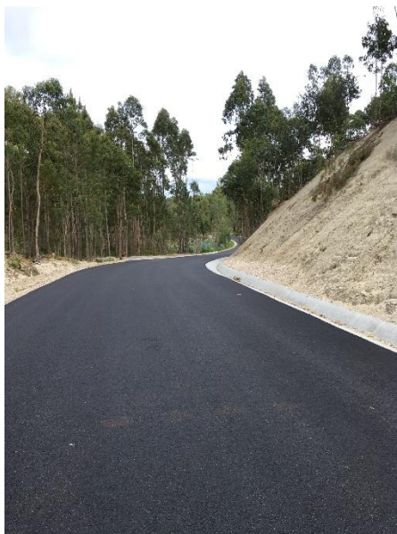
Figura 38 - Camada de desgaste aplicada.
