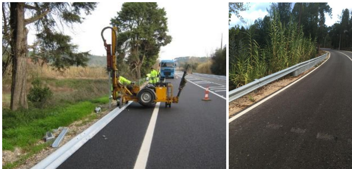
Figura 42 - Execução de barreiras de segurança com proteção para motociclistas.
