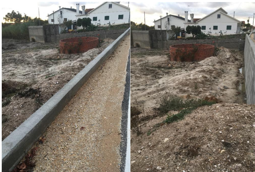
Figura 43 - Muro de contenção executado.
