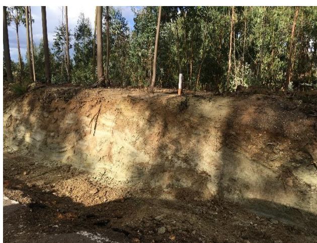
Figura 26 - Escavação em corte de talude para alargamento da via existente.
