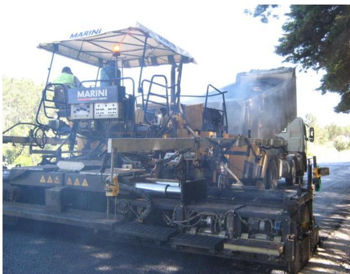
Figura 36 - Trabalhos de pavimentação com espalhadora.
