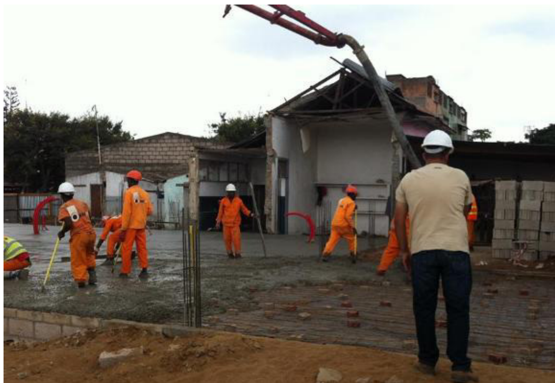
Figura 9 - Betonagem da laje
