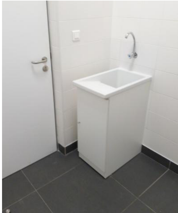
Figura 37 - Arrumos, zona de tanque
