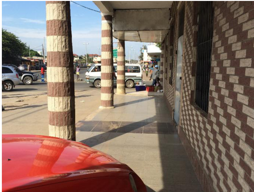
Figura 2 - Alpendre do edifício existente
