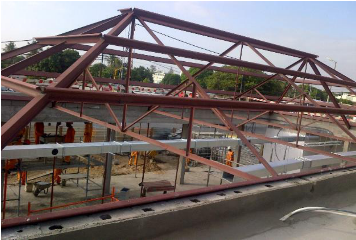
Figura 24 - Estrutura metálica da cobertura
