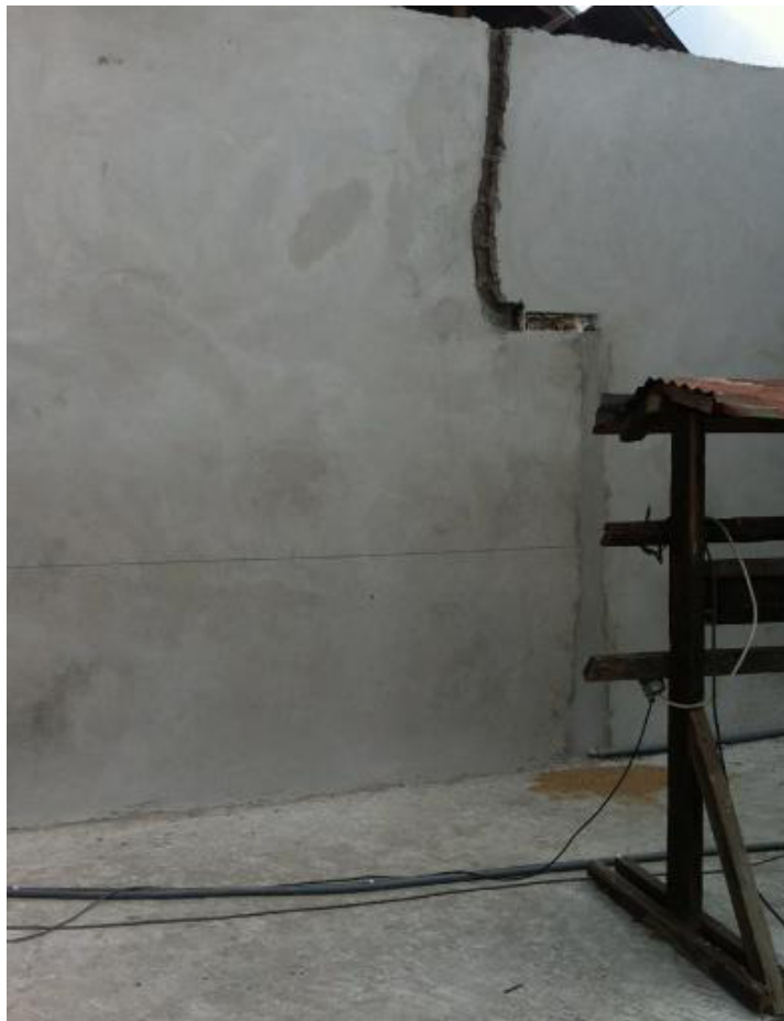
Figura 20 - Parede rebocada com negativo para maquina interior de ar-condicionado
