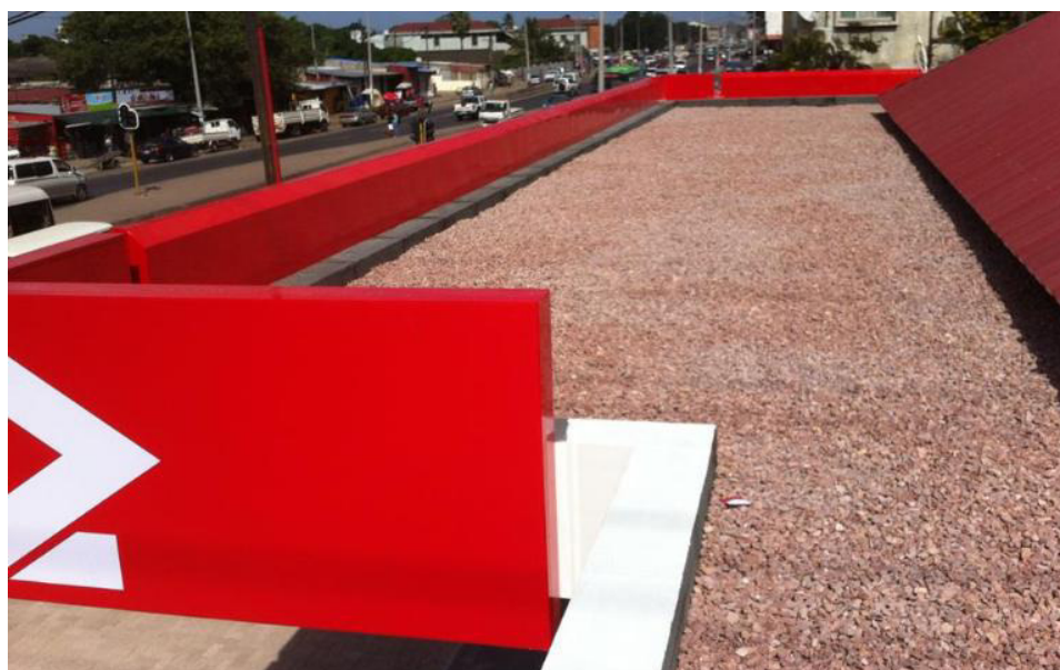
Figura 27 - Acabamento final do revestimento da cobertura
