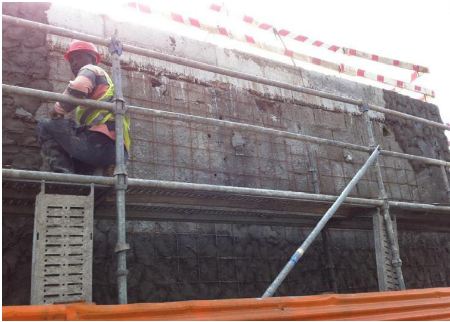
Figura 18 - Reboco armado em paredes do cofre
