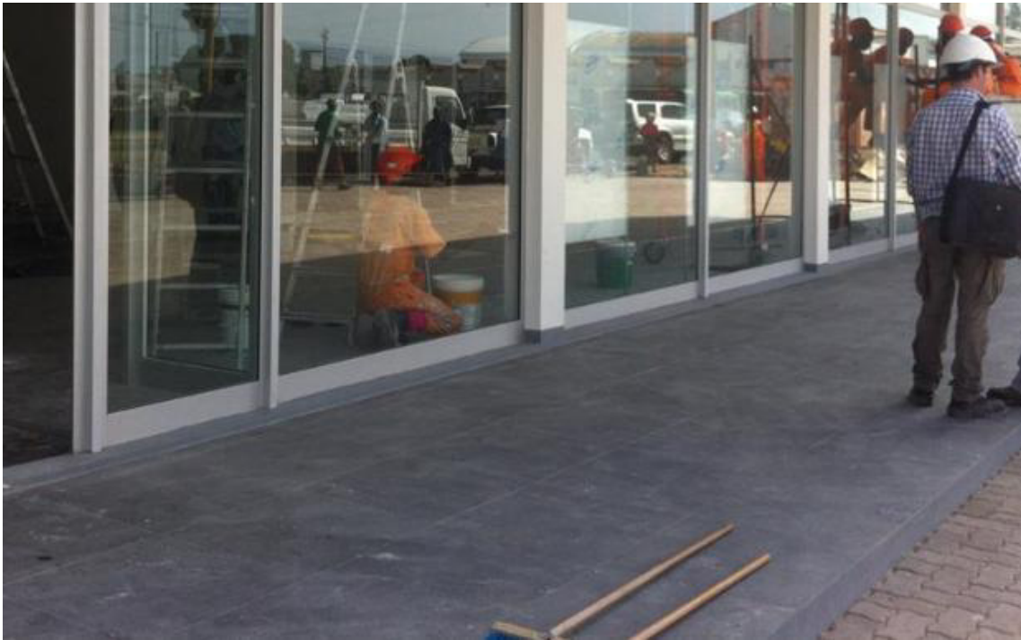
Figura 36 - Zona exterior, entrada para a agência
