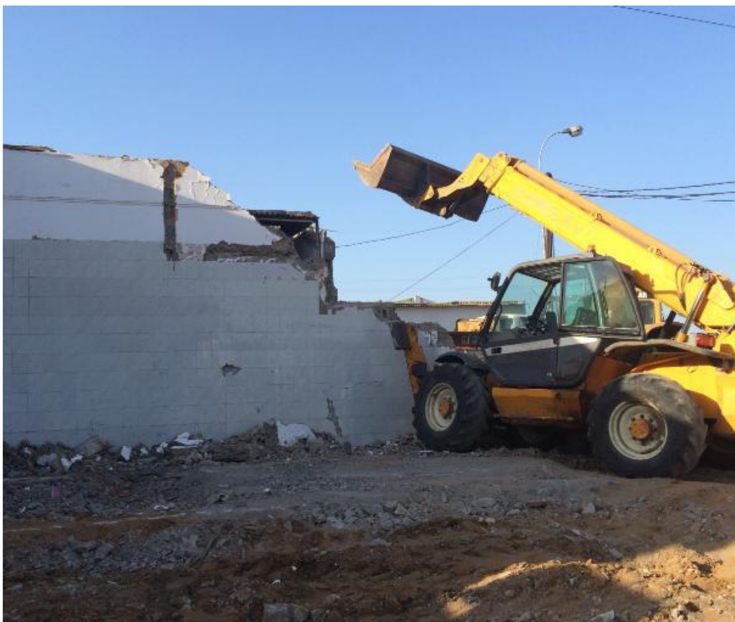
Figura 4 - Demolição do edifício existente
