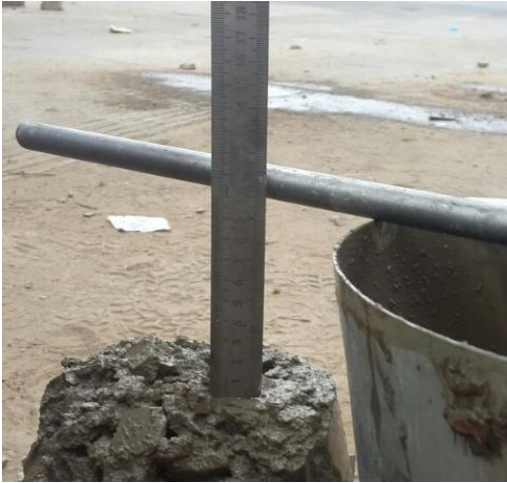
Figura 52 - Slump do betão
