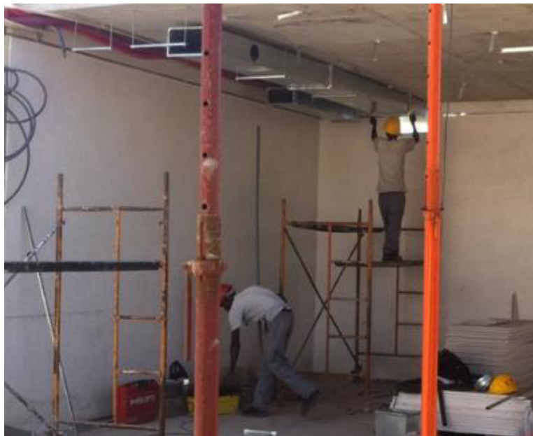
Figura 30 - Instalação de condutas de renovação de ar
