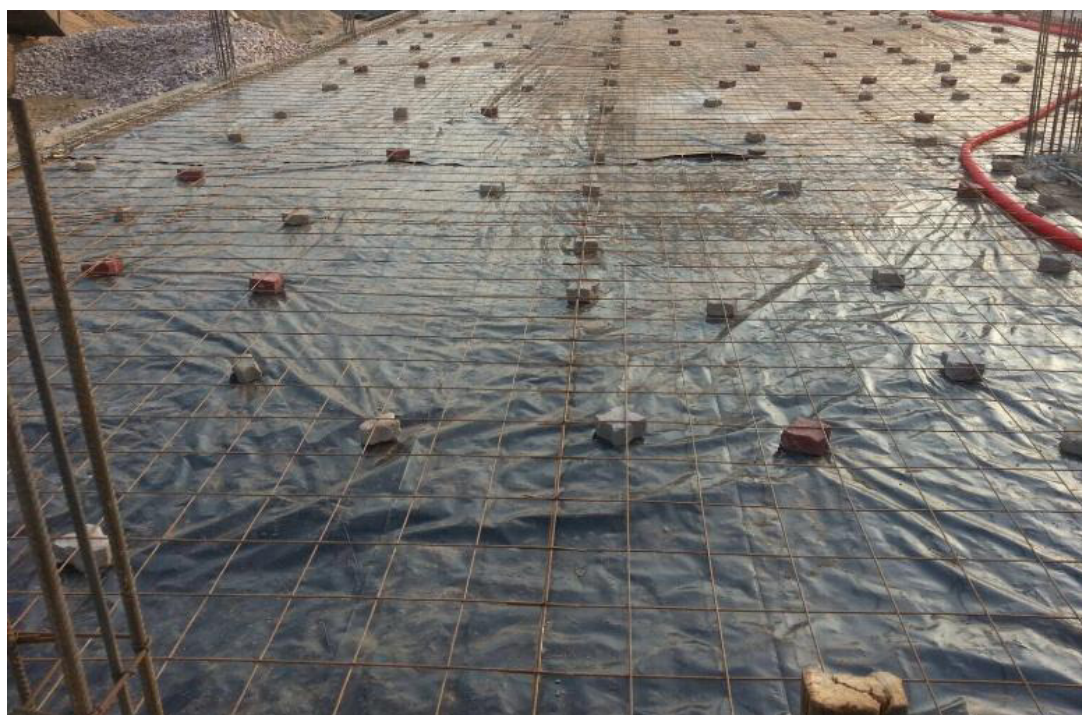
Figura 8 - Laje térrea antes da betonagem
