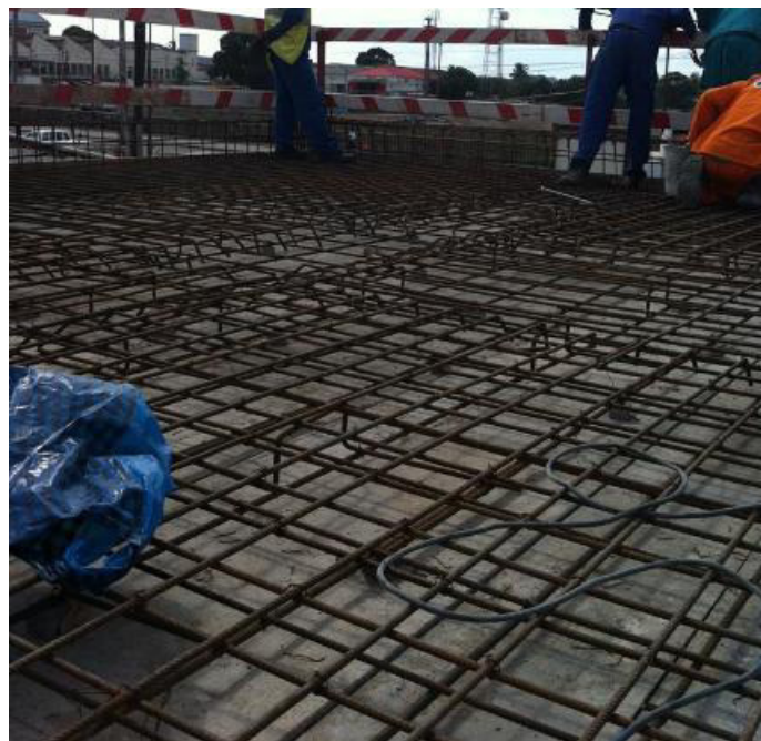
Figura 12 - Armadura da laje em consola
