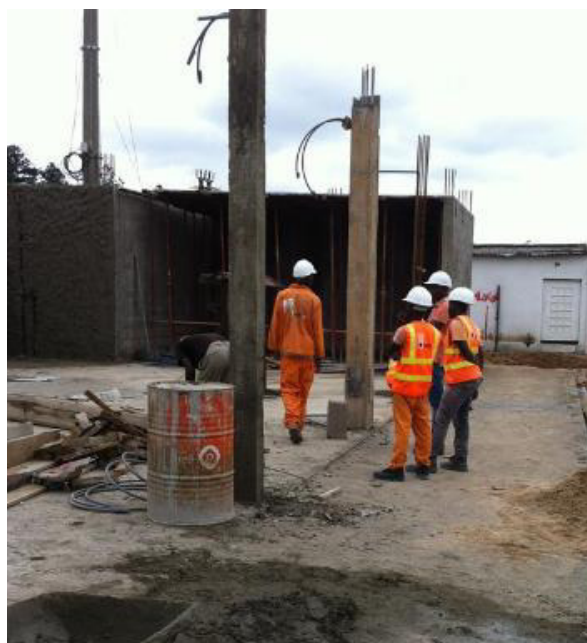
Figura 10 - Pilares, zona frontal da agência
