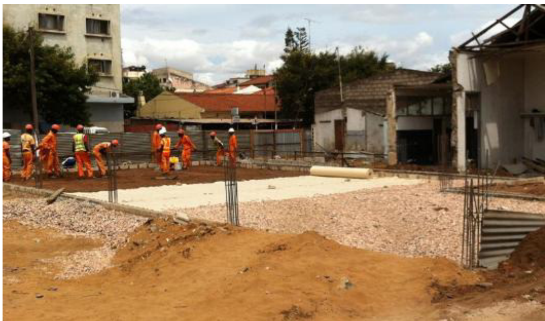
Figura 7 - Execução de caixa de brita e aplicação de geotêxtil
