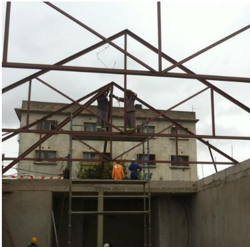
Figura 23 - Montagem das asnas metálicas
