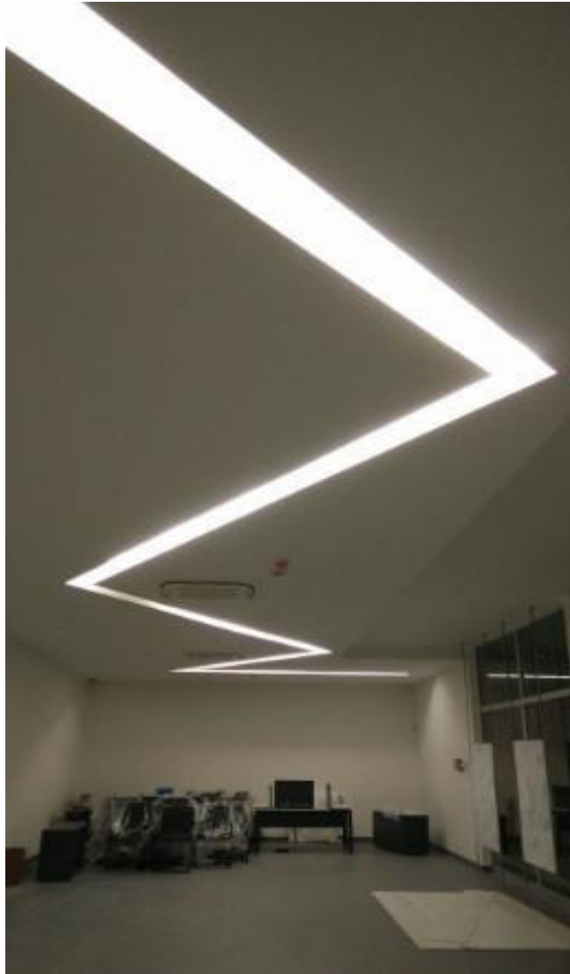
Figura 35 - Teto já com iluminação na zona de atendimento ao público
