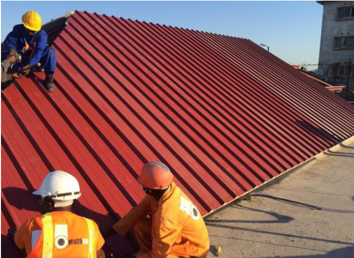
Figura 25 - Montagem do painel Sandwich
