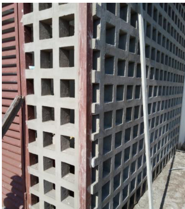
Figura 17 - Zona do gerador, alvenaria em grelha
