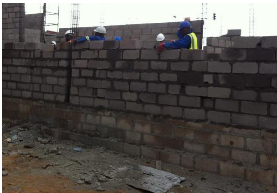
Figura 16 - Execução de alvenarias exteriores
