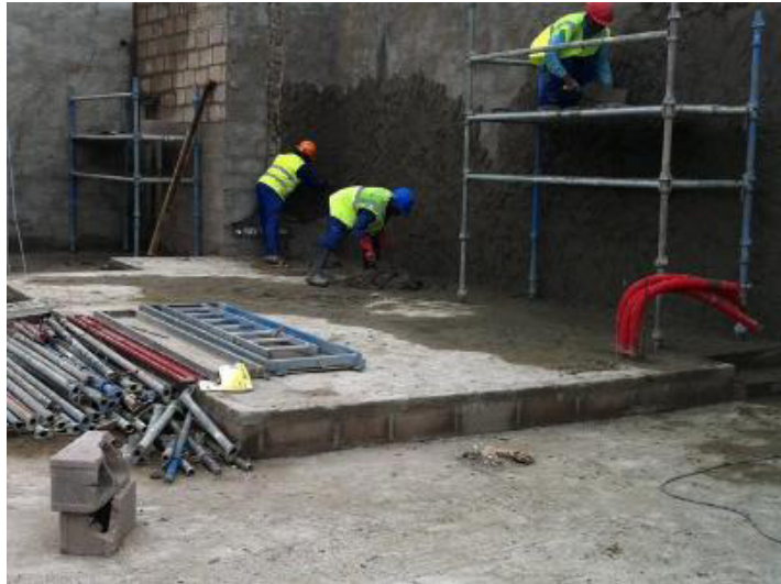
Figura 19 - Reboco das paredes da zona dos balcões
