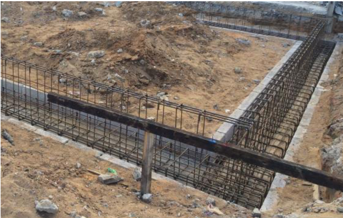
Figura 6 - Execução de sapatas com recurso a cofragem perdida
