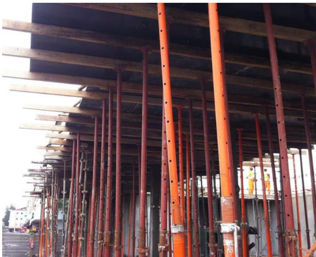
Figura 13 - Cofragem da laje em consola
