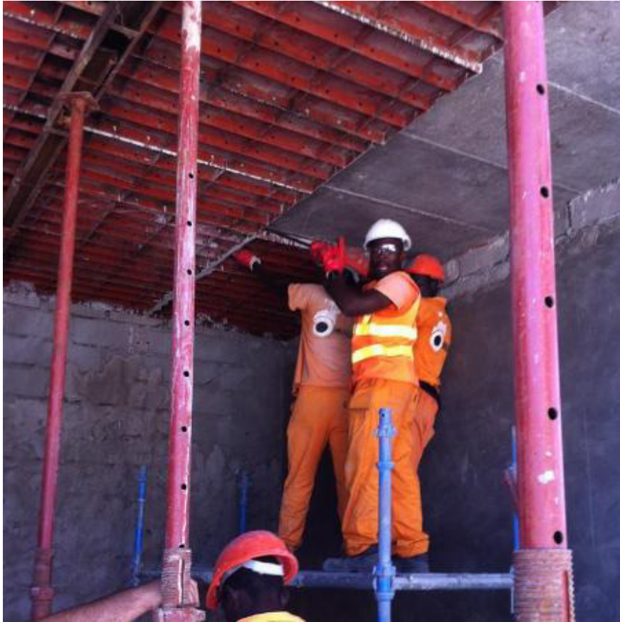
Figura 15 - Descofrarem de laje
