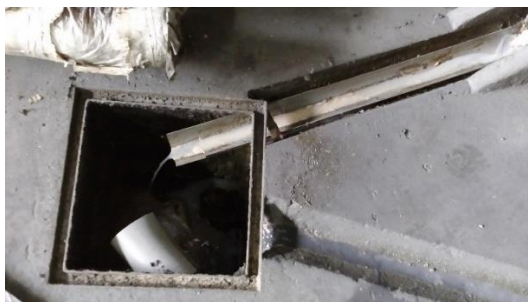
Figura 22 – Canais por onde segue o efluente da Nave 1 (Galeria Técnica 1).
